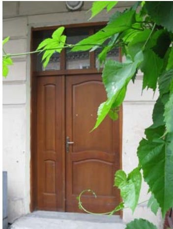
W M 245 ul. Kościuszki 16,16a,16b remont elewacji
