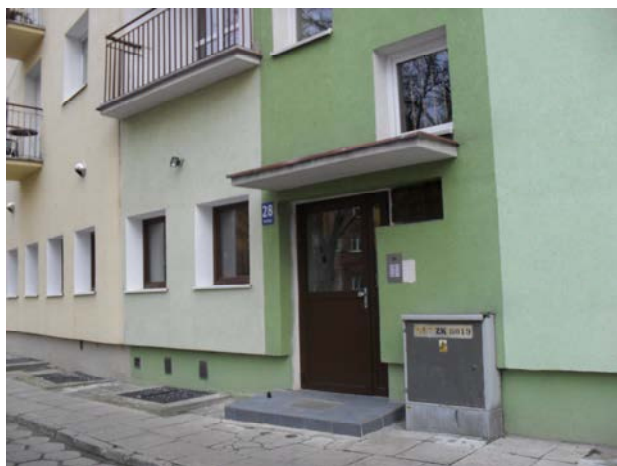
W M 1 ul. Rynek 27-31 remont elewacji i wejścia do klatek
