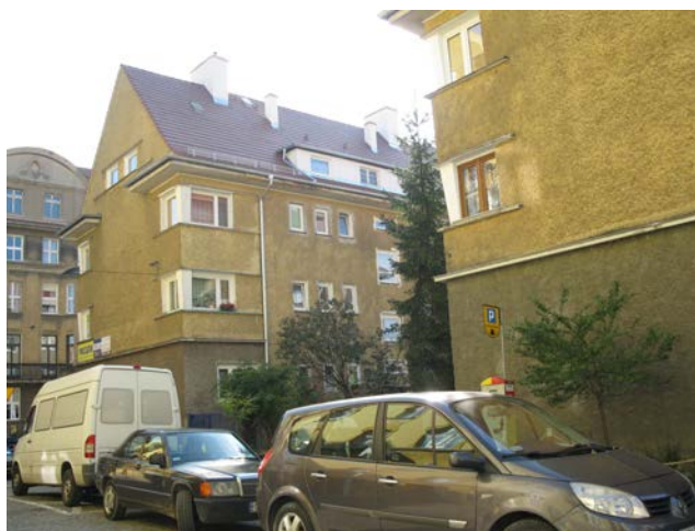
W M 153 ul.Boh.W-wy 6 remont dachu w ramach kredytu
