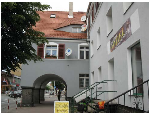
WM 131 ul. Prudnicka 11-15 remont elewacji z ociepleniem
