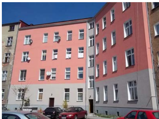
W M 127 ul. E.Gierczak 1,1a administrowana przez R.Szpargałę - remont elewacji
