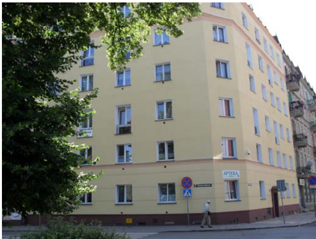
WM 109 ul. Moniuszki 1 remont elewacji z ociepleniem i remont wejścia do klatki
