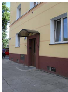
W M 109 ul. Moniuszki 1 remont elewacji i wejścia do klatki
