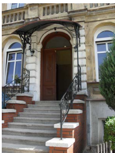
WM 269 ul. Słowiańska 9 remont wejścia
