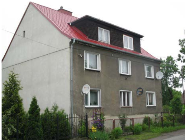
W M 195 ul.Radzikowica 5 w Goświnowicach remont dachu
